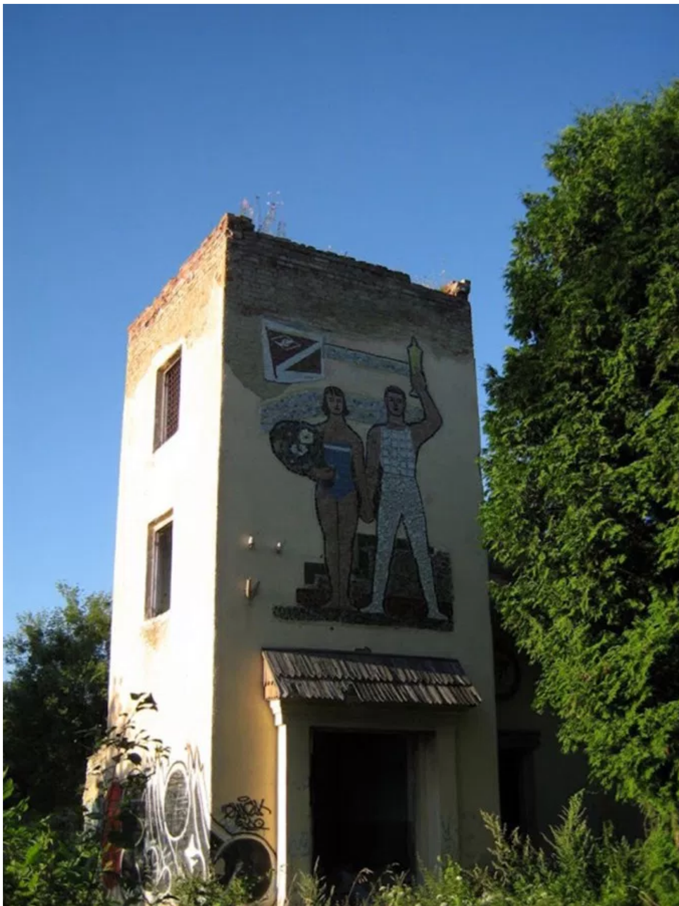
Мозаїка на адміністративній будівлі на території спорткомплексу "Спартак" до знищення. Фото: explorer.lviv.ua (2009 р.)
