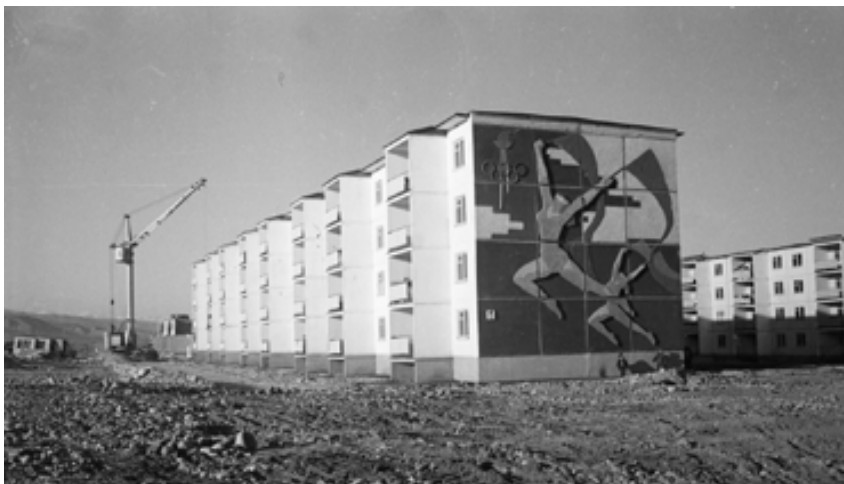
5-й микрорайон в г. Фрунзе. 1975. Материалы ЦГА КФД КР. Подпись на архивной карточке: «Экспериментальная группа по новой технике стендового цеха Фрунзенского домостроительного комбината разработала художественную облицовку для наружных стендовых плит»
